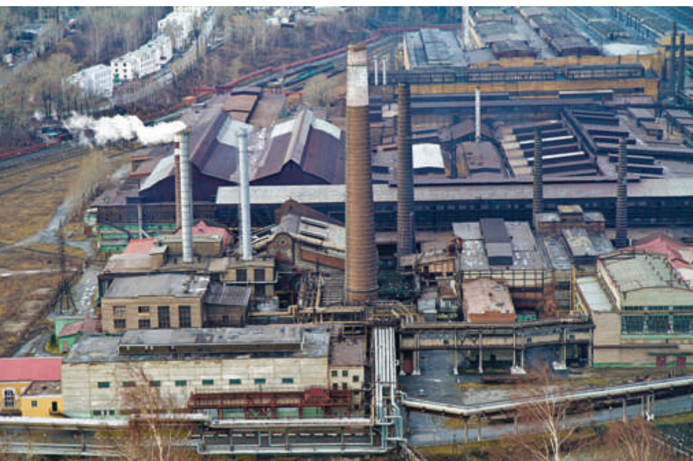
Златоуст (Челябинская обл.). Металлургический завод . Фото: Panoramio. Alexey Berezin
