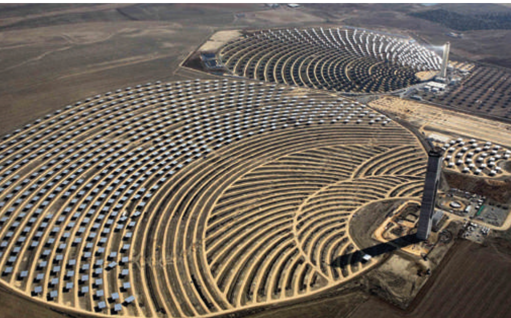
Солнечно-тепловая электростанция близ Севильи, Андалусия, Испания. Заметны колонны-концентраторы, на которые фокусируются лучи многочисленных зеркал. На переднем плане — строящаяся очередь (пущена в 2009 г.). Фото: Wikipedia
