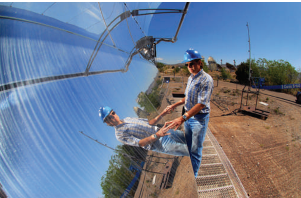
Монтаж зеркала-концентратора
