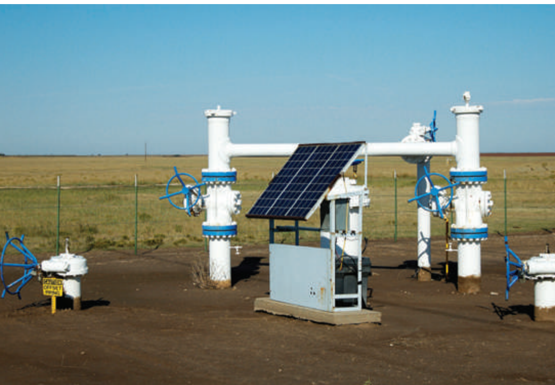
Станция мониторинга трубопровода в штате Техас. Электроэнергию вырабатывает солнечная батарея
