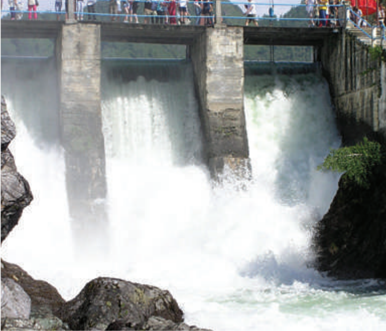
Чемальская ГЭС. Здесь река Чемал впадает в Катунь. Фото авторов
