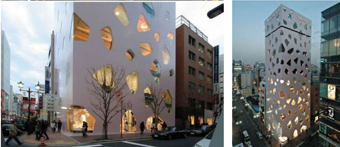
Рис. 6. Будівля Мікімото в Токіо
