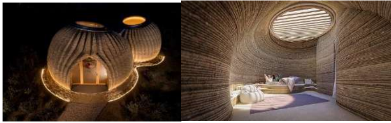
Рис. 1. Будинок з сирієї землі, надрукований на 3D-принтерах
